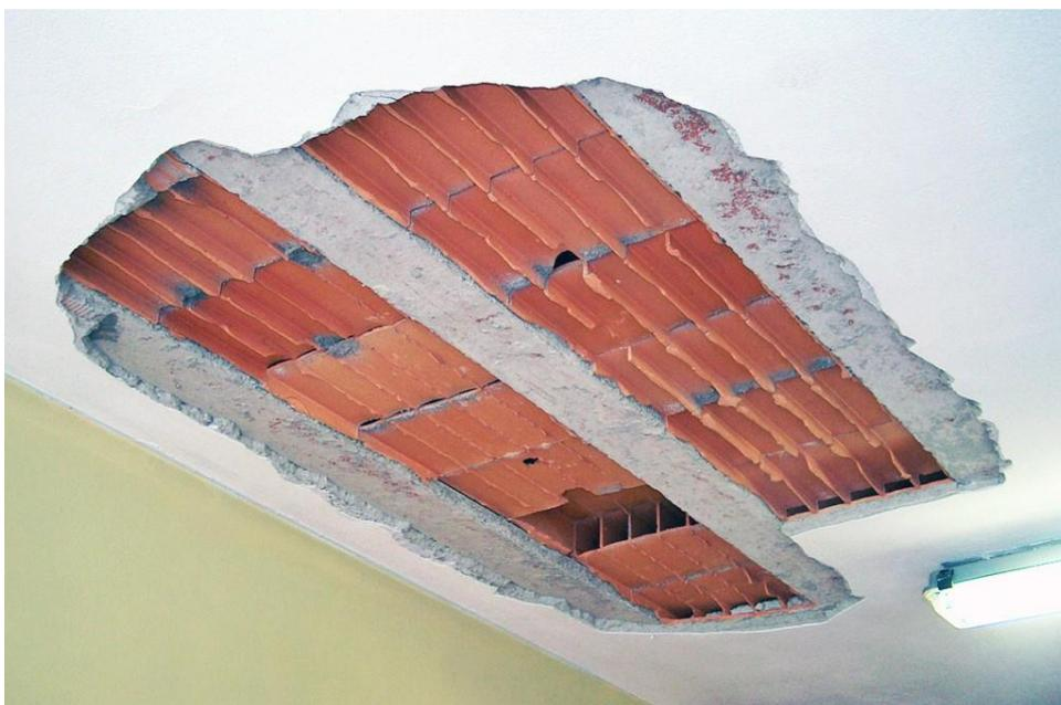
Lo sfondellamento è il distacco e la successiva caduta della parte inferiore delle pignatte o dell'intonaco. Quando i componenti non strutturali del solaio, pignatte e intonaco, si degradano avviene lo sfondellamento. Il solaio mantiene la sua capacità
