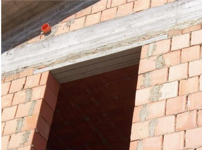
suo peso ed eventualmente quello delle strutture superiori che sostiene. Essendo in genere strutture che nella parte centrale sono sospese nel vuoto, esse hanno un limite di utilizzo in base al peso che vi viene appoggiato sopra e alla resistenza del materiale.
