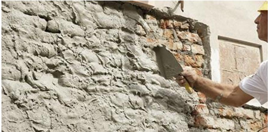
Il **secondo strato** è definito **arriccio** o **arriciato** o **intonaco rustico**, ha una granulometria media (circa 1,5 millimetri di diametro massimo) e viene applicato in spessori che variano da **1,5 a 2 centimetri**, rivestendo così il ruolo di vero e proprio scheletro di tutto il sistema intonaco. Il suo principale compito è quello di uniformare la superficie delle murature, andando ad **eliminare tutti**
